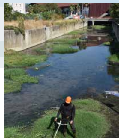
Entretien des berges et des cours d'eau, ici la Frayère, afin d'éviter les embâcles et la prolifération des végétaux.
